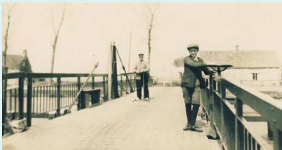
Op 4 september 1917 geeft raadslid Jan Verweij B&W van Alkemade in overweging om de brugwachter van Nieuwe Wetering een pet met rode band te laten dragen. Brugwachter Van Leeuwen, hier met zijn zoon op de draaibrug, draagt overduidelijk zijn ambtelijke pet zoals het betaamt. Foto: F. Volwater
